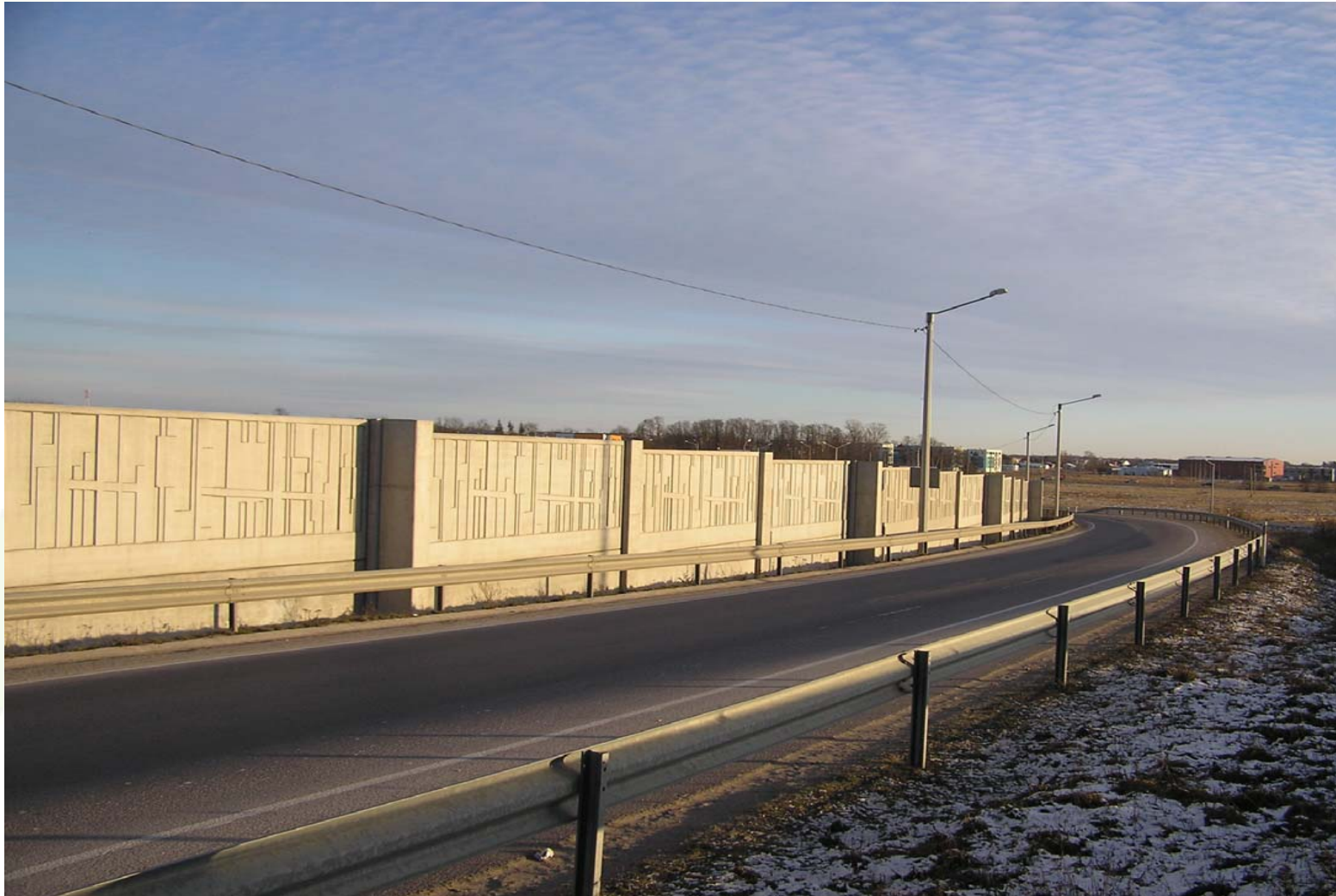
Joonis 8. Pildiküla betoonmürasein
